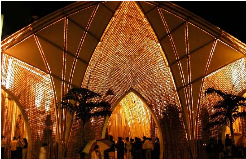
Cathédrale catholique temporaire, Pereira, Colombie (construction en 2004, destruction en 2005) © Simón Vélez
